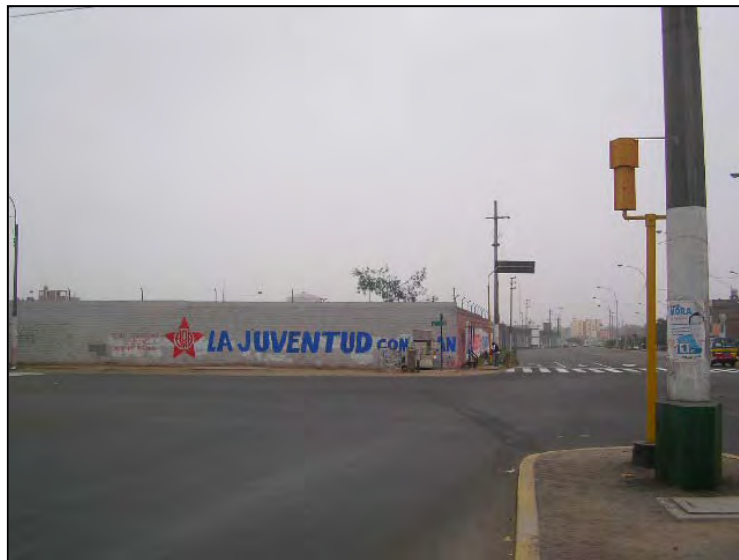
Figura 8.3-4 Discontinuidad del carril vehicular debido al establecimiento ilegal de una fábrica (Av. Venezuela)
