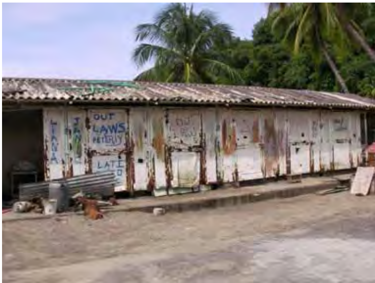
漁具倉庫道路側の概観
