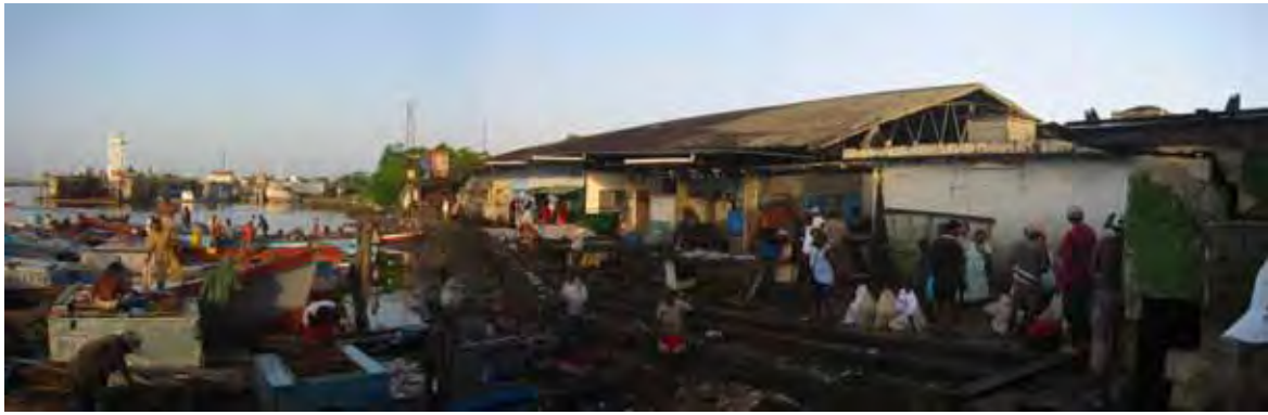
公設中央市場裏護岸部（水揚場）の状況：川下側から撮影現況（干潮時）
