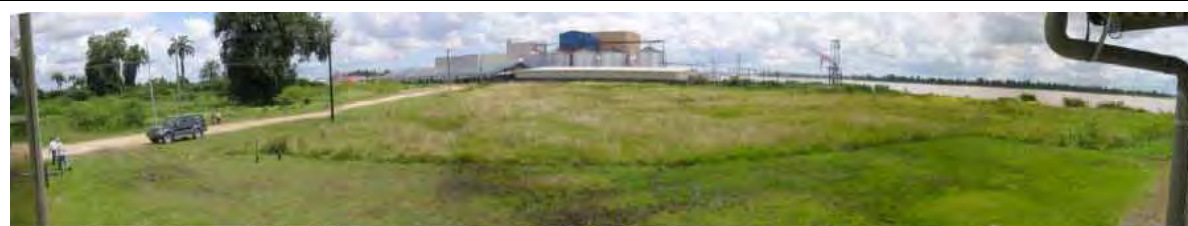
プロジェクトサイト全景（セヴィハス側から撮影：2006年7月22日） 中央奥の建物はモーレン社（製粉会社）のサイロと工場
