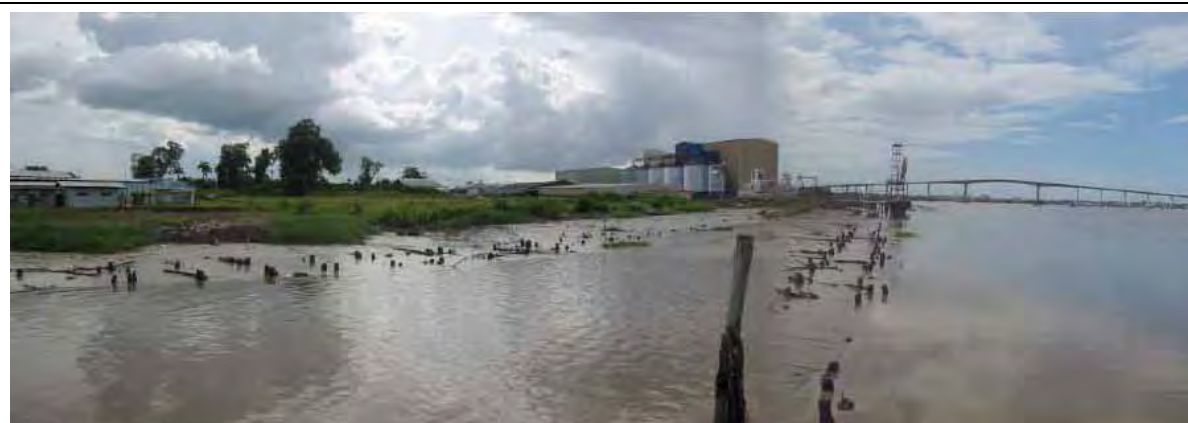
プロジェクトサイトの現況（干潮時）：（上流側セヴィハス社棧橋から撮影） 水際付近の川底形状は、この水際線までは勾配がゆるく浅いが、その先は急角度で深くなっている。
