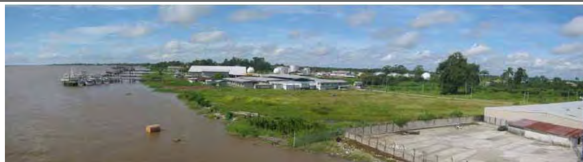
プロジェクトサイトと周辺の全景（下流側モーレン社棧橋から撮影） 左中央手前がセヴィハス社（国営水産会社）の棧橋、その奥にSOL石油会社の棧橋がある。 中央手前の建物群がセヴィハス社で、大屋根の建物が漁船の建造・修理工場である。
