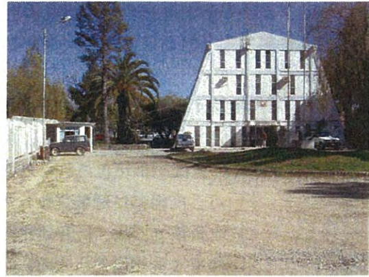
サイト構内にある先住民農業開発局の建物。手前のスペースがセンター建設候補地である。
