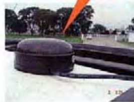
Instalación antena GPS
