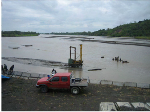
写真-2 レイ側橋台調査状況
