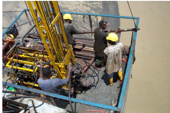
写真-3 P3橋脚調査状況
