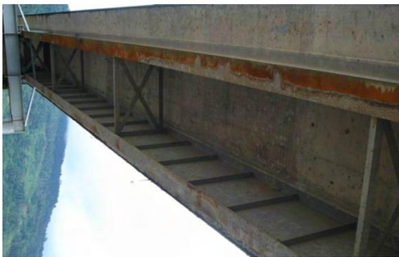
写真-6 鋼桁の錆の状況
