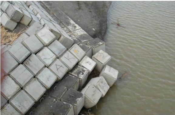
写真-9 レイ側下流のブロック崩落
