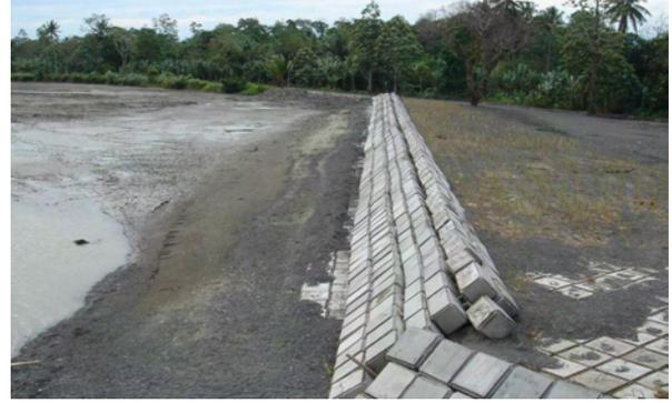
写真-8 レイ側上流の護岸工
