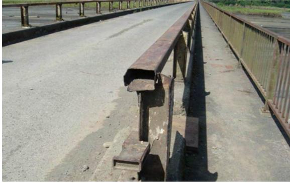
写真-7 ガードレールの損傷状況
