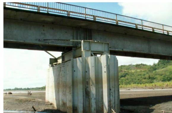
写真-4 P3 橋脚補修状況
