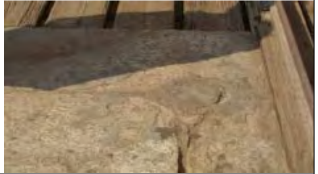
1951/52年実施の堰柱グラウト孔キャッピング
