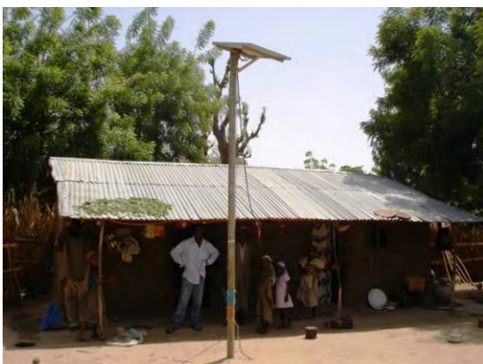
5) SHS 外観。PV モジュールの仕様は BCS と同様に 60W。屋内には蛍光灯 15 W×2 灯と DC 用コンセントを設置。バッテリーは 65Ah の密閉式。
