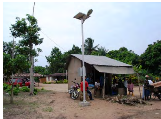
6) 街路灯外観。PV モジュールの仕様は SHS と同様で 62W。バッテリーも同様 60 Ah の密閉式。照明装置は蛍光灯(20W)。照明点灯時間は 4 時間/日(日没後 4 時間)とした。
