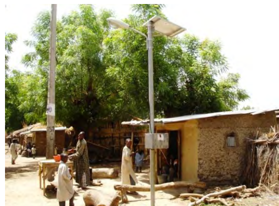
6) 街路灯外観。照明装置は 18 W のナトリウム灯。照明は 6 時間/日 (日没後 4 時間、日出前 2 時間) 自動に点灯する。PV モジュールは仕様は BCS と同様に 60W。バッテリーは SHS と同様に 65Ah。
