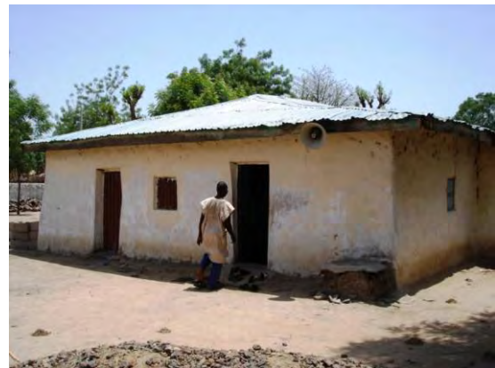
4) 公共施設 (モスク) 外観。蛍光灯 15W×12 灯を設置。DC 負荷として 10W の拡声器を利用中。
