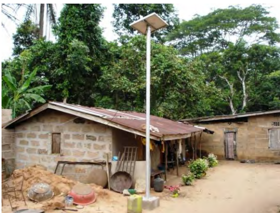
5) SHS 外観。PV モジュールの仕様は公共施設と同様で 62W。屋内には蛍光灯 11W×2 灯と DC 用コンセントを設置。バッテリーは 60Ah の密閉式。
