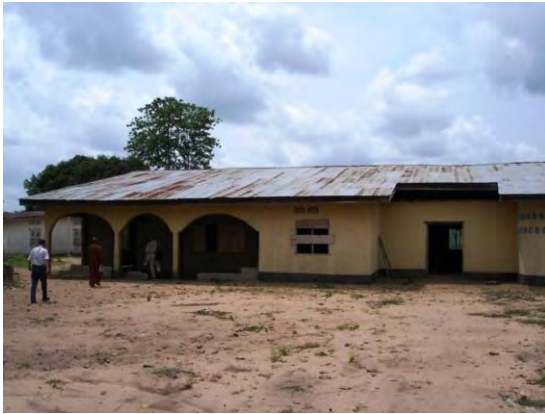
1) 公共施設(集会所)外観。蛍光灯 11W×12 灯設置した。
