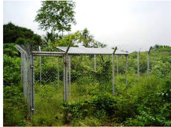
2) PV アレイ外観。公称最大出力 496W (62W×8 枚)。PV アレイは傾斜角 15 度、方位南向き。
