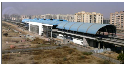
建設中の Dwarka 第 10 地区駅
