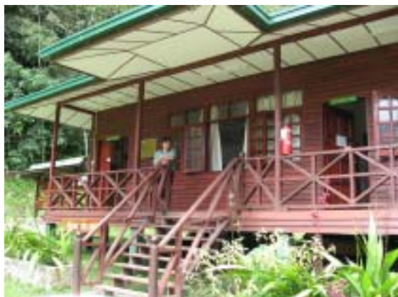
クロッカー山脈公園マファ・サブステーション
