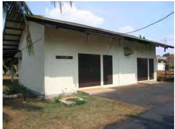
写真 4: 受変電室 現状では、受電容量の不足は無く、施設が適切に維持管理されており、電気設備の問題は報告されていない。
