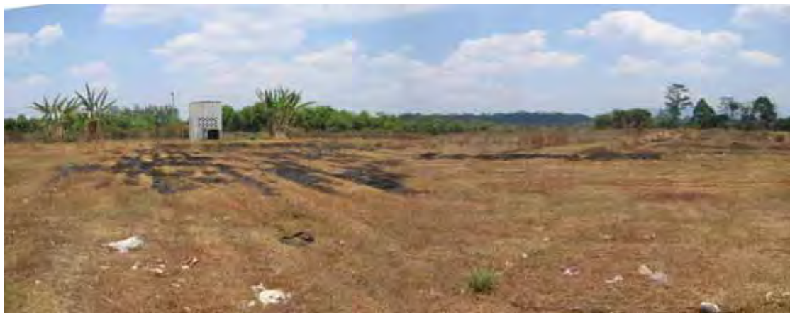
写真 4: 管理人住居側から計画敷地を望む。写真の中央から左側に見える建物は、深井戸用施設である。
