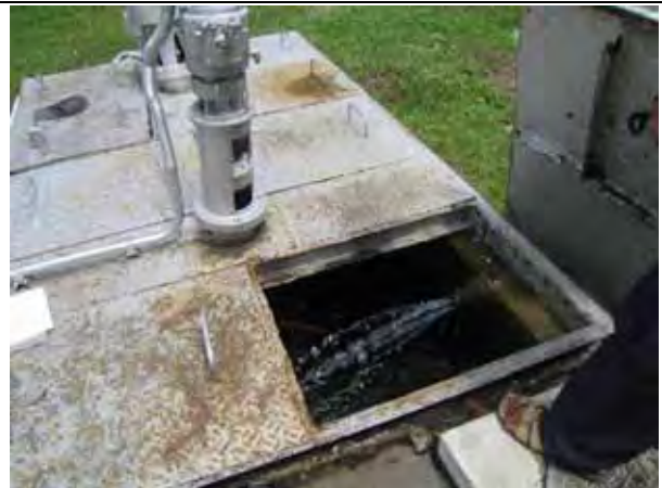
写真 6: 公共水道取入れ口 メダン地域の給水需要が供給に追いついていないため、給水量の不足が生じている。
