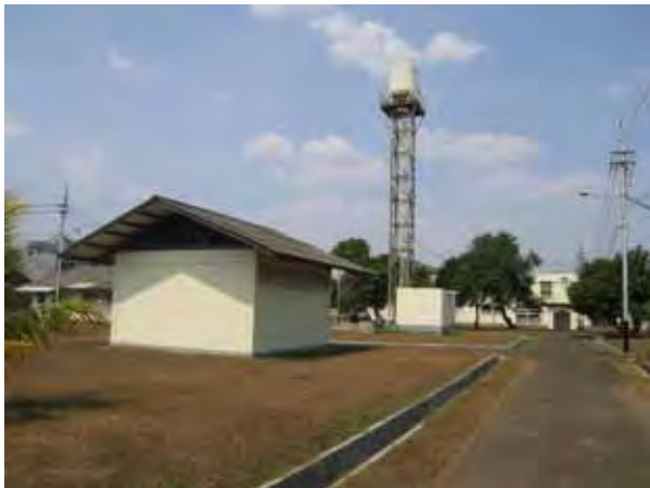
写真 3: 給水塔 建設後約20年が経過しているが、施設が適切に維持管理されており、給水設備の問題は報告されていない。
