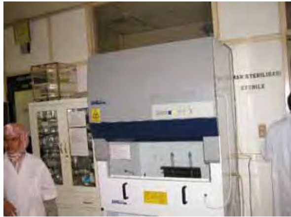
写真 2: 安全キャビネット(Napco 製、Napflow9 型) ウイルス検査室の床に設置されている。2002 年に設置され、使用している。
