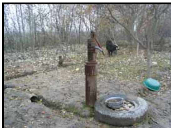
農村平野部のタギナマック村（カハラモン）。村民によって設置されたポンプつき浅井戸で、水の濁りがあり、飲料水としては水質は基準以下。
