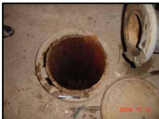
チュベックジャモアットの Saidov 農場、2002年にUNDPがリハビリした2本の井戸の1本の井戸、2006年に再び故障して修理不能となっている
