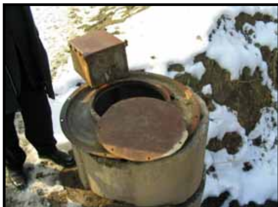
山間部キョンチャシマ村（チュベック）の湧き水取水用井戸。村落全体で共有している。供給量は少ないため、民間業者からの買水に依存している。
