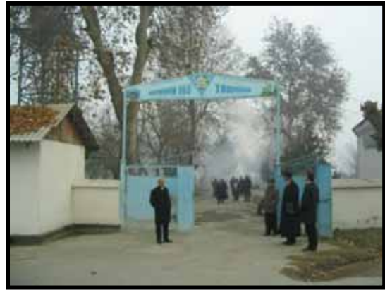
モスコフスキー上下水道公社の正門。敷地内に全ての取水施設がある。敷地面積は凡そ2ヘクタール。
