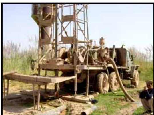
タジキスタン農村水道建設公社の保有する2台のロータリーテーブル方式のリグのうちの1台の稼働状況、1970年代ソ連製 URB-2MA-2、かなり老朽化し計画対象地域の玉石層を掘削することは困難
