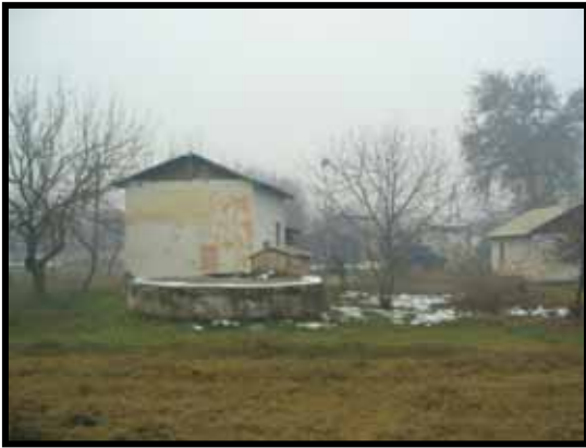
モスコフスキー上下水道公社敷地内の深井戸（4基のうち2基は停止中）。地下式水源井で円筒形構造物の地下に井戸がある。
