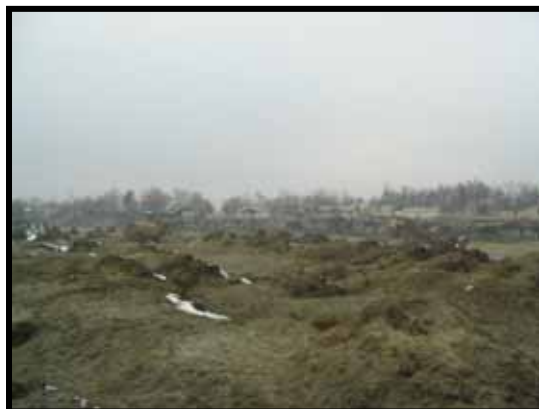
洪水により全壊したアンジルコン村（カリニン）の給水施設。取水施設場所の変更を含めた新規給水施設の建設が必要である。
