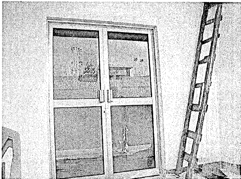
UPPER BLDG. ENTRANCE DOOR
