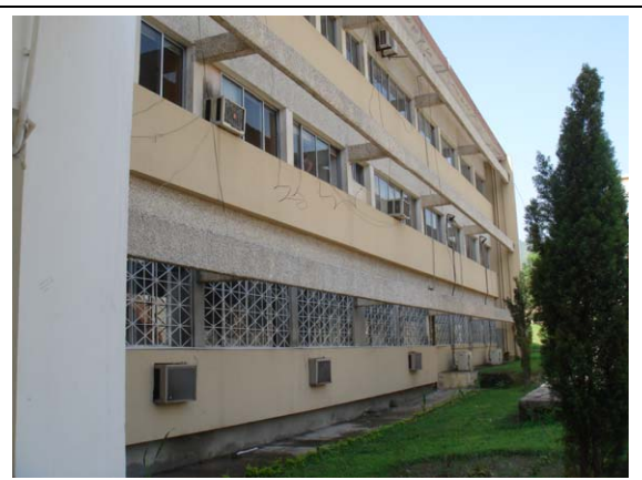
地震のダメージを殆ど受けなかった鉄筋コ ンクリート建造物
