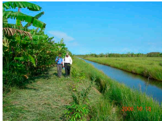
写真5 ; L字水路（法面が刈り払われている）
