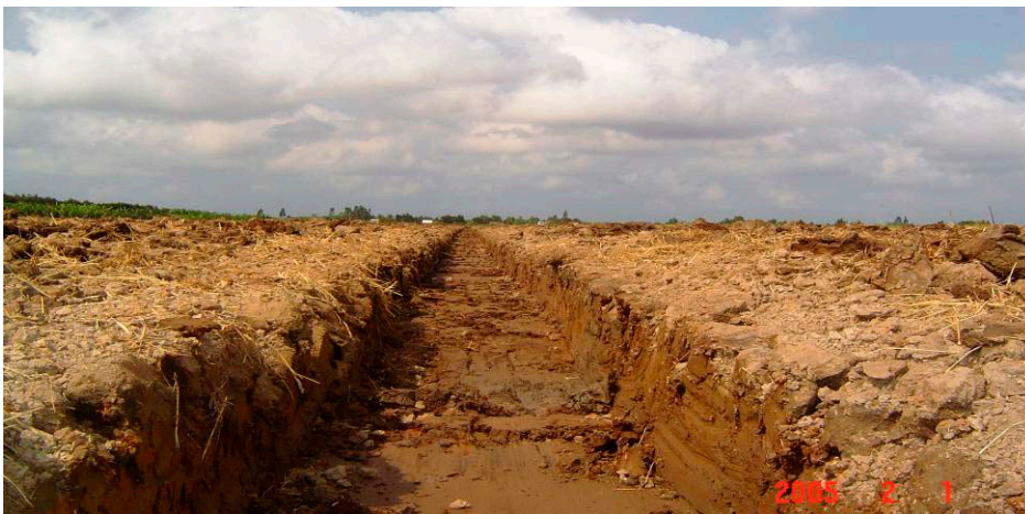
写真 3 ; 施工直後のエンバンクメント (造林技術マニュアル)
