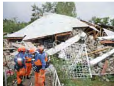
倒壊した家屋
