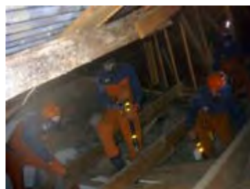
DHQ病院 屋根裏から削岩中
