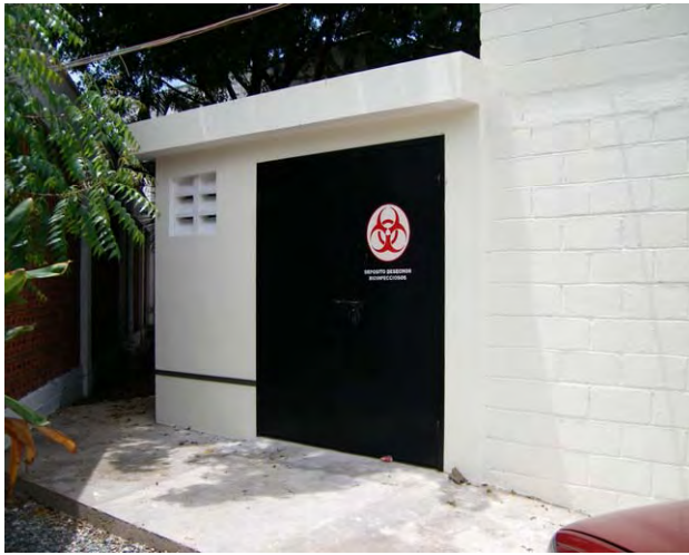
感染性廃棄物一時貯留施設
