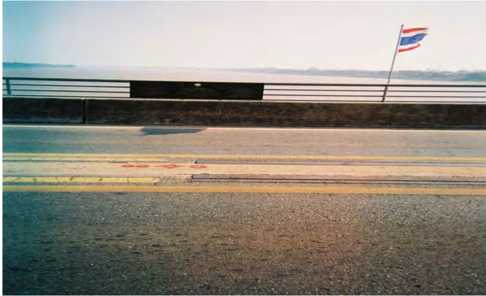
友好橋上の国境：タイ側（右側）の線路が敷設
