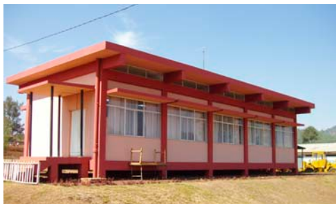
食堂・厨房棟（北東面）
