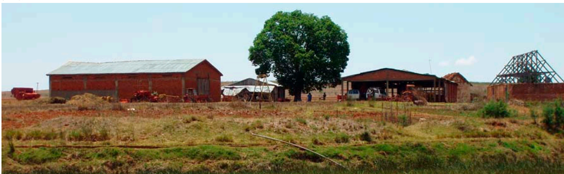
既存建物群全景（南側より）
