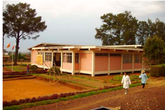
管理棟（南西面）
