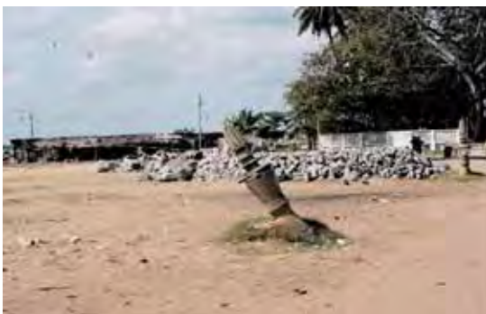
（津波で傾いた門柱 ニゴンボ）
