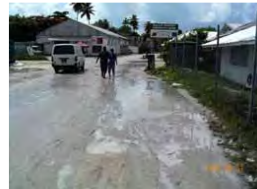
写真 8: 排水施設・歩道がないため歩行者が車道を歩き、事故の原因となっている。
