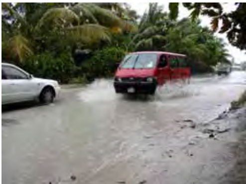
写真 7: 道路の地覆とハンプに囲まれた部分は表面水が流れず、冠水被害が深刻化している。
