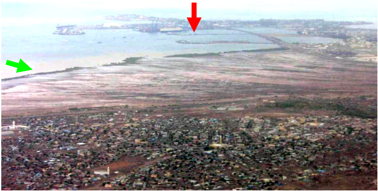
ジブチ港 (→) とその周辺地域の状況 (中央部がワジ Ambouli デルタとマングローブ帯→)
