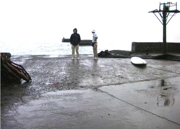
タジュラ港フェリーターミナル施設
