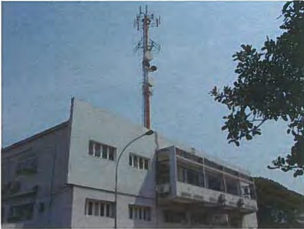
ベンゲラ電話局の外観とアンテナ
