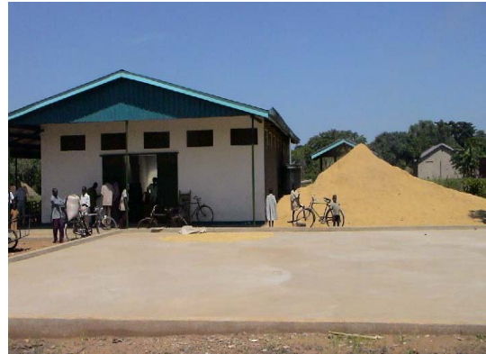
パイロット事業で建てた精米所
