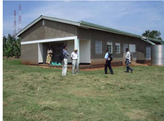
パイロット事業で建てた加工場
