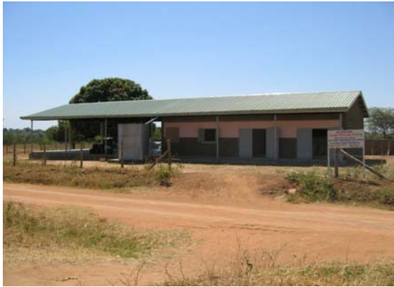
パイロット事業で建てた製粉所
