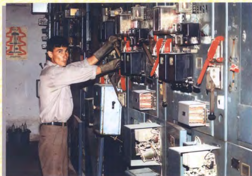
Энергетическое сердце Сартамгалинского водозабора - подстанция 35/6 КВА. Оперативные переключения эл.оборудования в ЗРУ - проводит дежурный эл. щита для обеспечения бесперебойной подачи эл. энергии к оборудованию.
