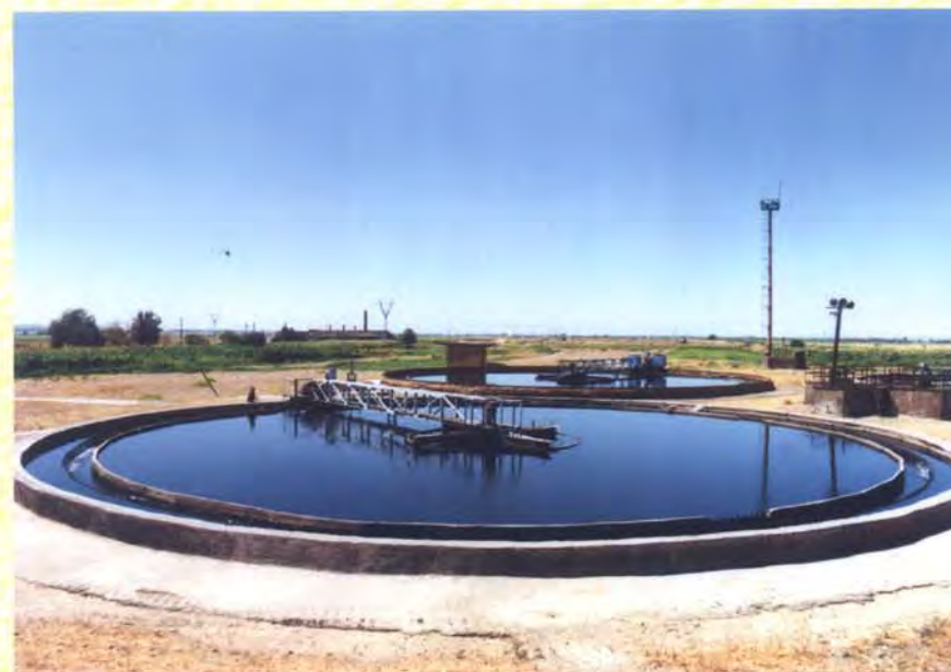
Вторичные отстойники сооружение для биологической очистки сточной воды. В процессе очистки воды в этом сооружении развиваются полезные микроорганизмы и выпадают в осадок продукты распада органических веществ.
