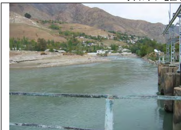
⑦取水地点上流側
