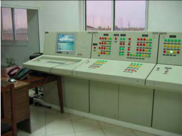
③中央管理室
