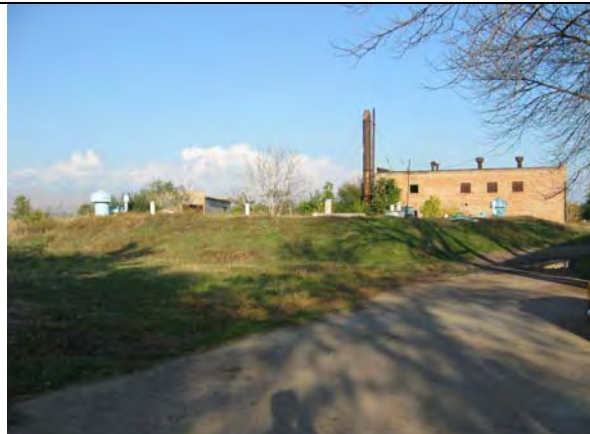
④取水地点内浄水池
