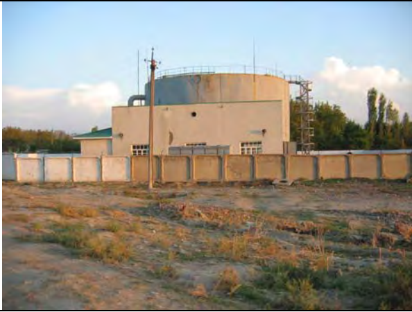
⑤鋼製配水池
