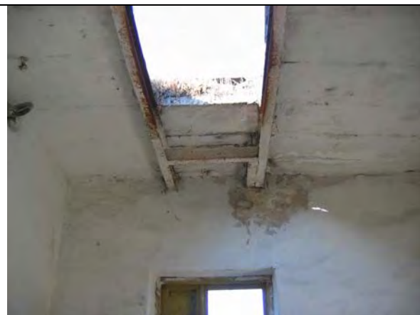
②地下水揚水ポンプ建屋
