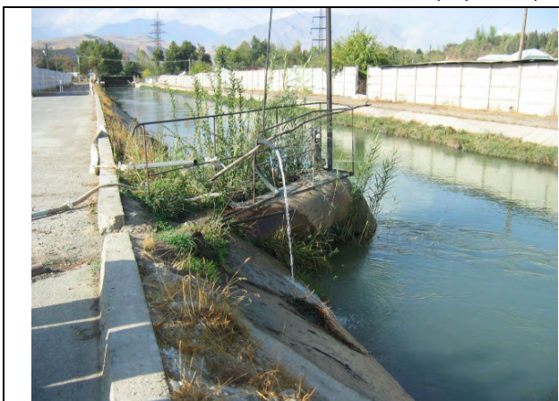
①ナポールナヤ取水浄水施設
