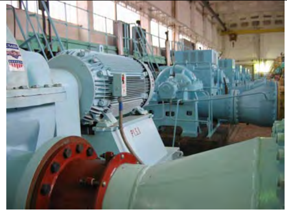
⑥USAIDによるポンプ更新
