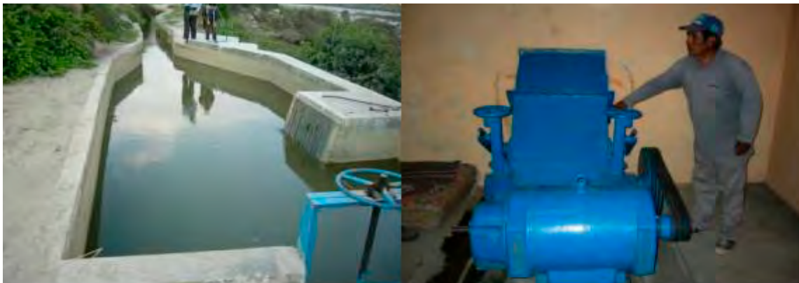
既設水路を改造したヘッドタンク
