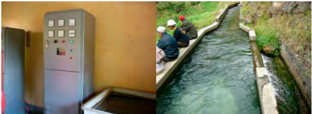
制御盤とダミーロード水槽
