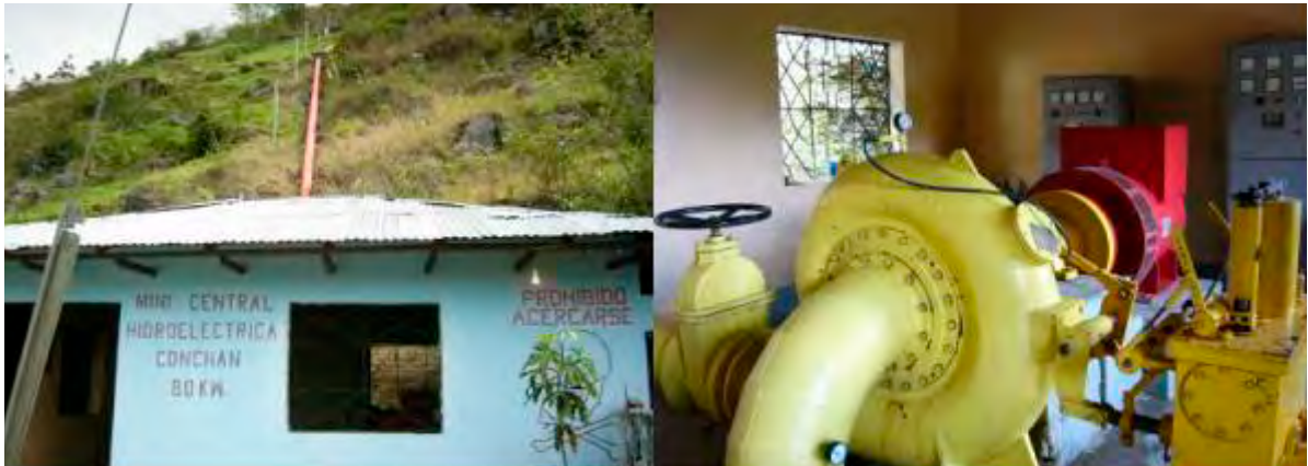
発電所と水圧鉄管
