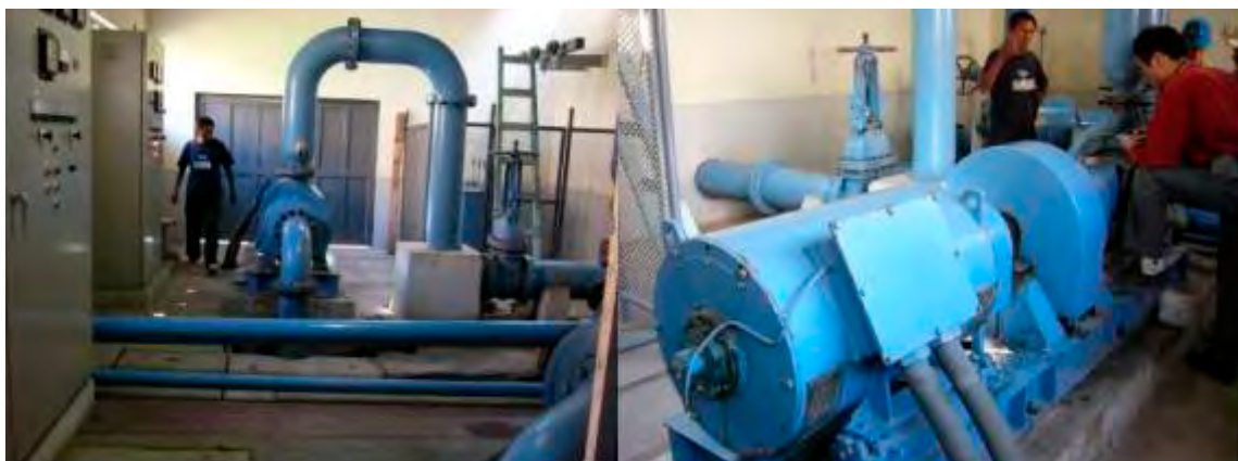
発電所内部の様子
