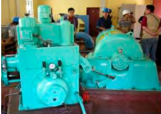
中国製水車発電機
