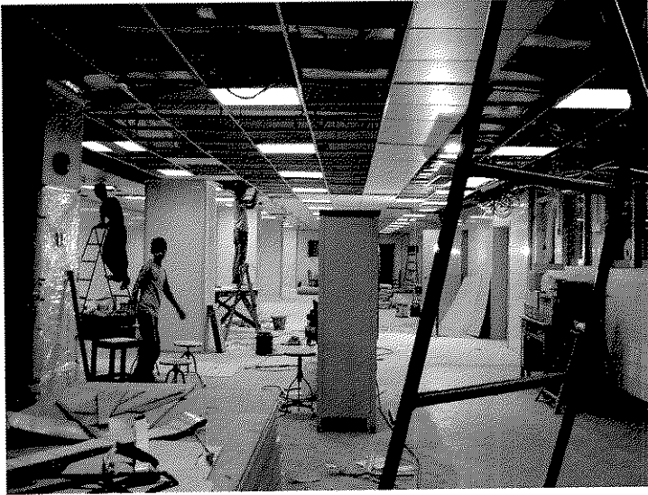
広州医学院第一附属医院の改修中の検査室。
