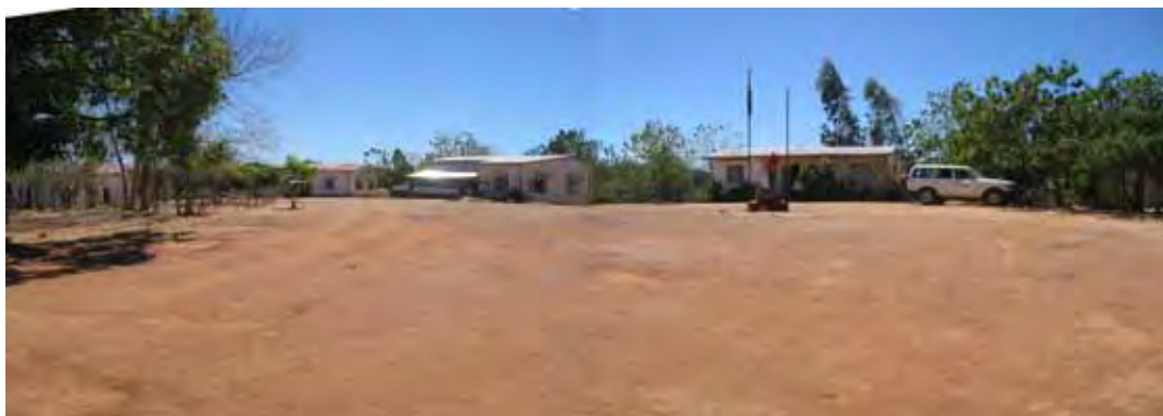
敷地全景 2 左側から仮教室棟（旧食堂）、管理事務棟、職員宿舎、秘書室棟
