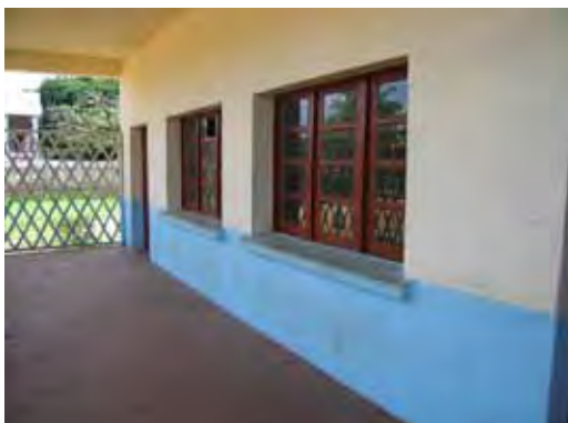
改修済みの廊下の外壁と木製ガラス窓
