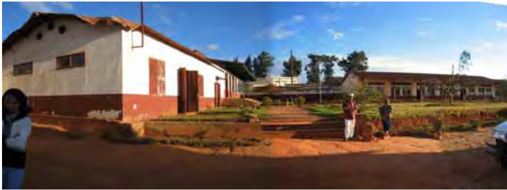
敷地全景 1 左側が管理事務＋講堂棟、右側が一般教室棟
