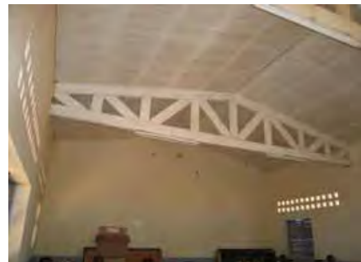
教室内部の天井、木造トラス
