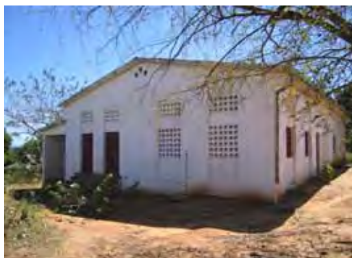
仮教室棟外観（旧食堂・厨房棟）
