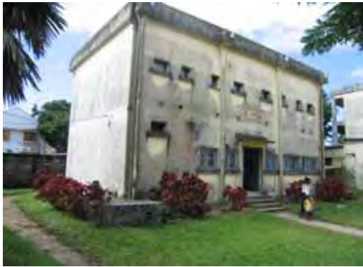
管理事務棟外観 (DREN敷地内の建物1階を間借り)
