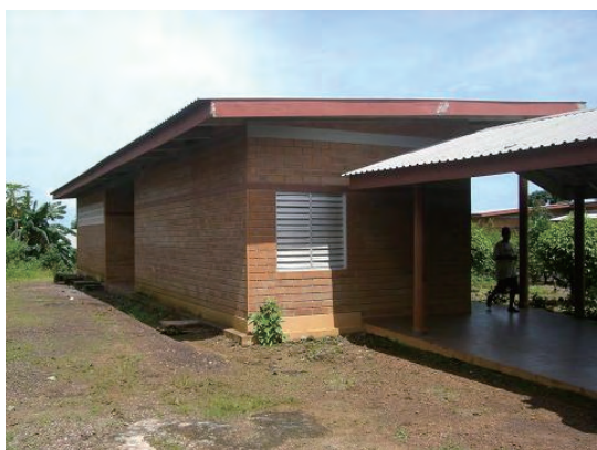
日干し煉瓦を壁に採用した ルクセンブルクの案件（盲学校）
