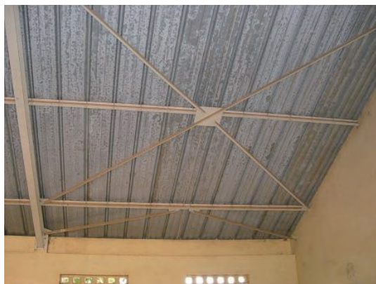
鉄骨フレーム (ブレース)
