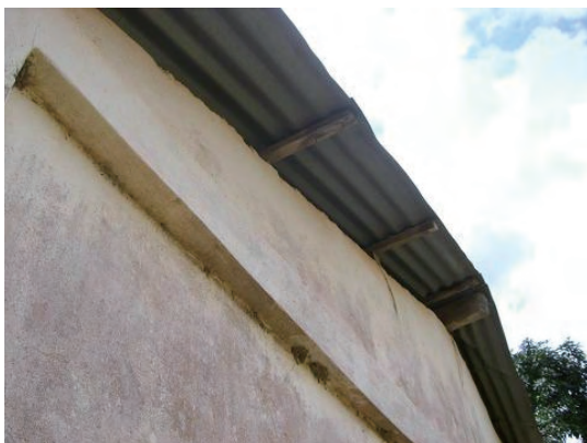
外観 (妻側見上)
