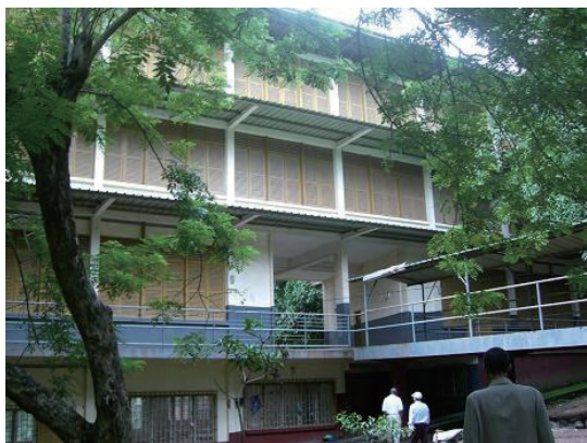
教室棟（地下1階地上3階建）
