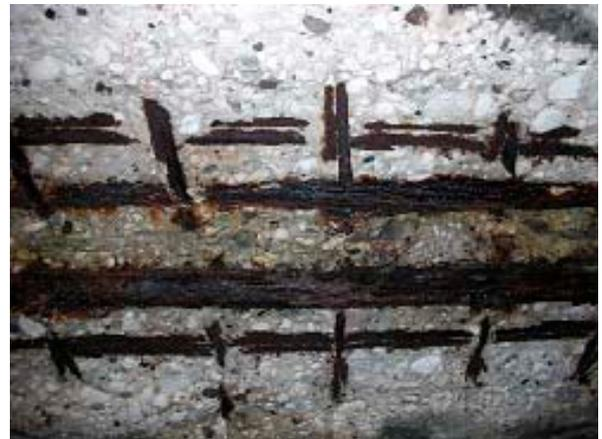
写真9 鉄筋の腐食の状況
