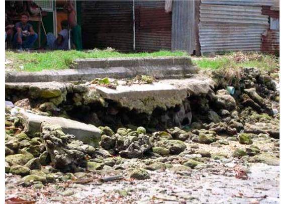
写真7 護岸基礎崩壊の状況
