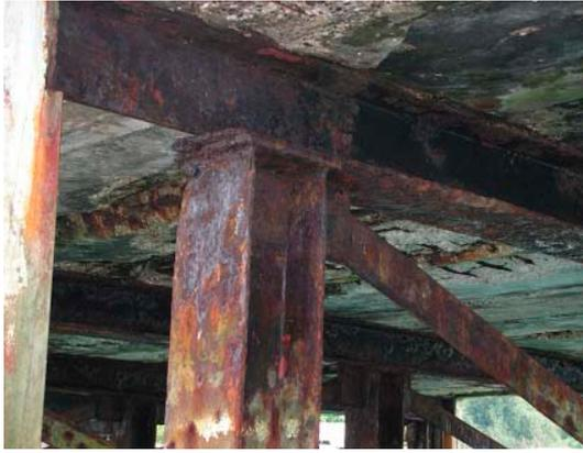
写真 10 H鋼杭頭の腐食の進行の状況
