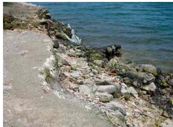
写真 13 栈橋取り付け部周辺護岸の崩壊の状況
