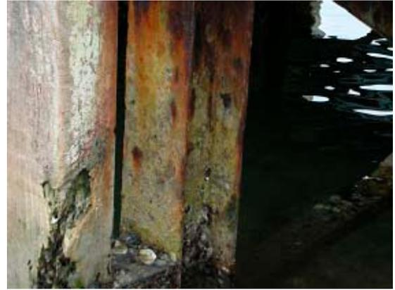
写真 11 断面が痩せたH鋼杭
