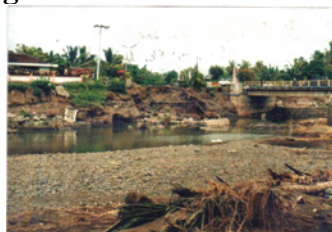
Jembatan Bilok Poh dan sisi hulu yang runtuk setelah banjir
