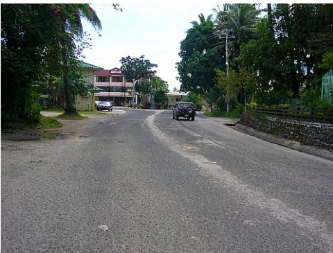
Section D STA. 0+050 Ravelling
