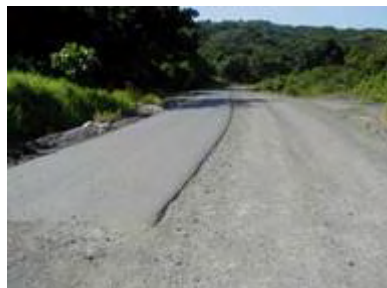
【施工途中の区間】
