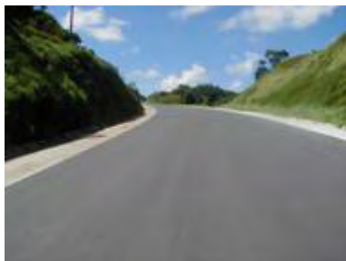
【表層工が終了した区間】
