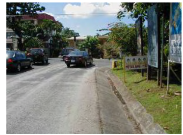
写真 4 車と側溝の隙間がない
