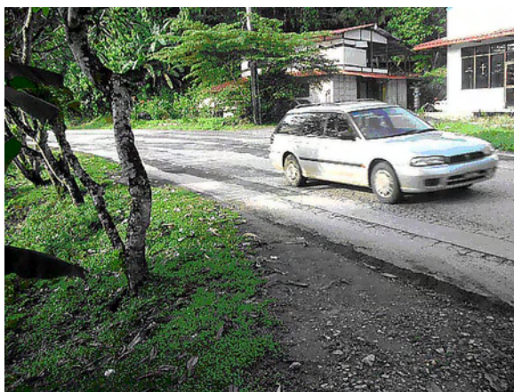
写真-11：アイライビューホテル付近の舗装損傷箇所 樹木の傾きから、損傷は地滑りによる路盤沈下が原因と思われる。
