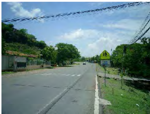
Foto 1-3-1 Paso de peatones y señales de advertencia actuales
