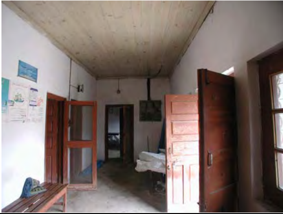
損傷は見当たらない外来診療棟
