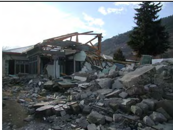
倒壊したスタッフ居住棟
