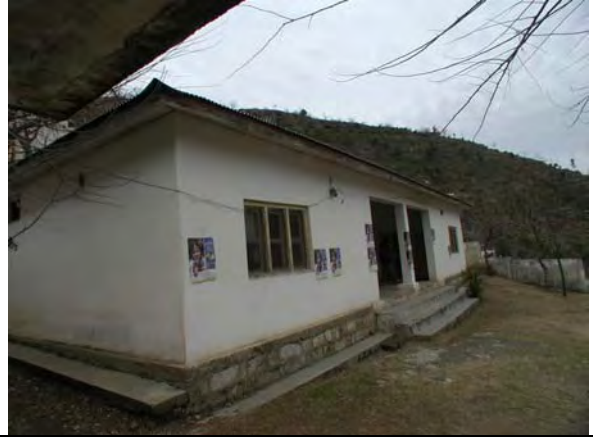
損傷が見当たらない外来診療棟
