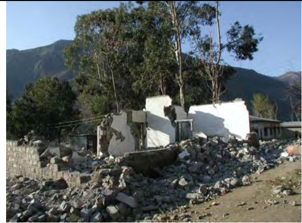
崩壊した守衛住居
