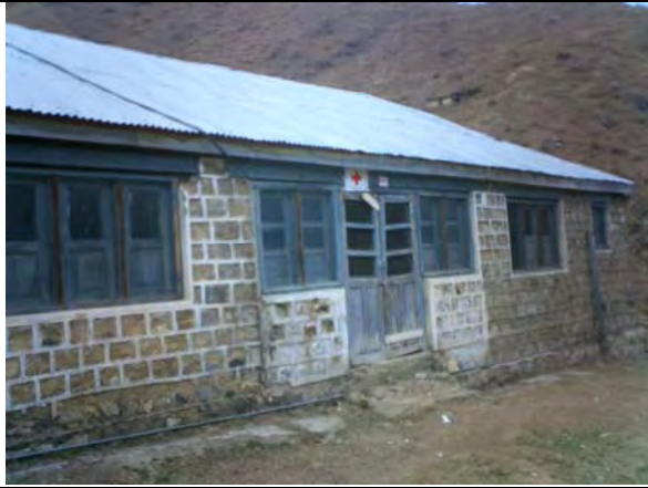
損傷がない外来診療棟
