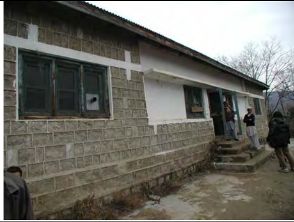
損傷が見当たらない外来診療棟
