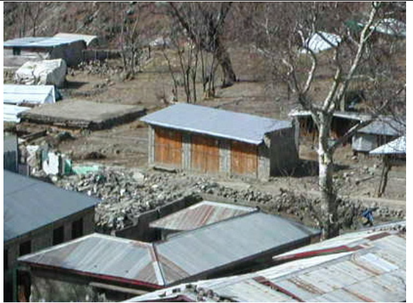
外来診療棟崩壊跡
