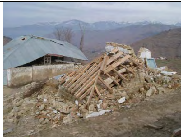
大きく損壊、倒壊しているスタッフ住居
