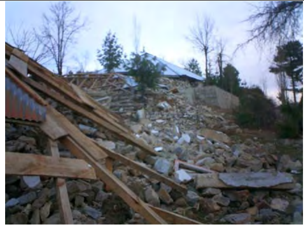
倒壊しているスタッフ住居
