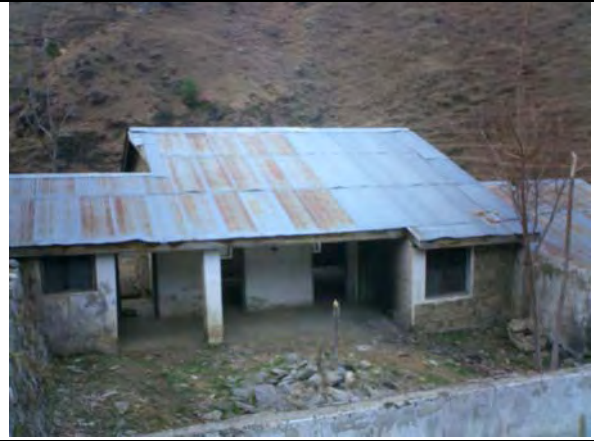
損傷がないスタッフ住居
