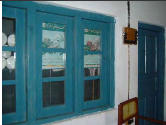
窓周りにも亀裂は見当たらない
