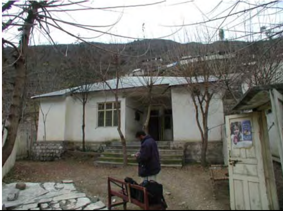
損傷が見当たらない医師住居
