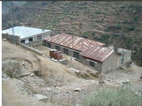
施設全景(損傷は見当たらない)
