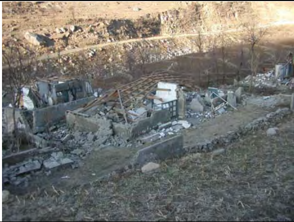
崩壊した外来診療棟と病棟
