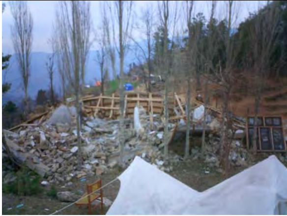
大きく損壊している外来診療棟
