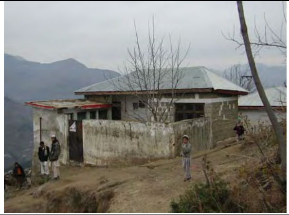
損傷は見当たらないスタッフ住居
