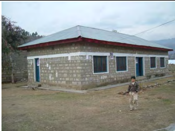
損傷が見当たらない外来診療棟
