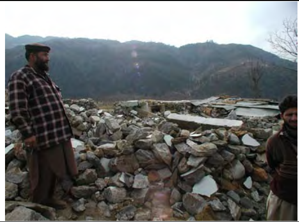
完全に崩壊したスタッフ住居
