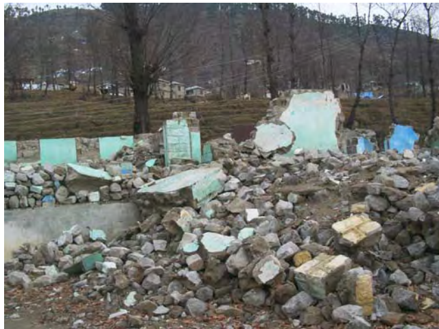
5 教室棟が完全に崩壊
