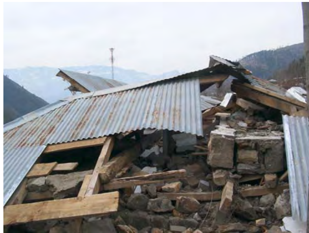
3 教室棟が完全に崩壊
