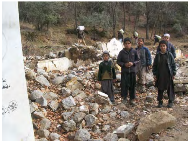
3 教室のうち 2 教室が完全に崩壊
