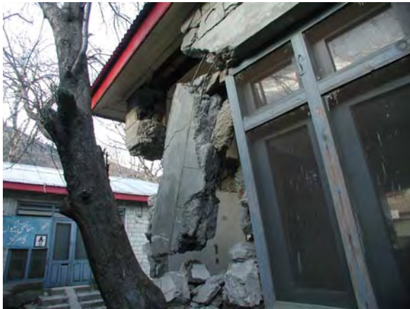
試験室及びレントゲン棟
