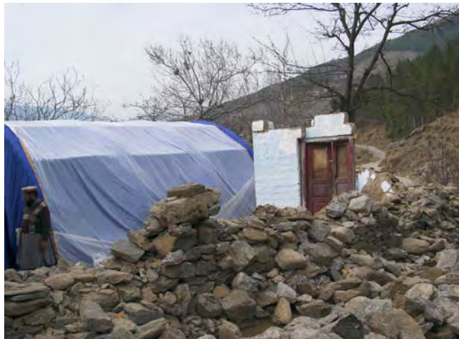
2 教室棟が完全に崩壊
