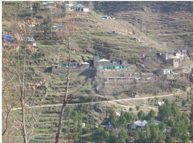
地滑り・法面崩壊の危険のある区間が多くみられる
