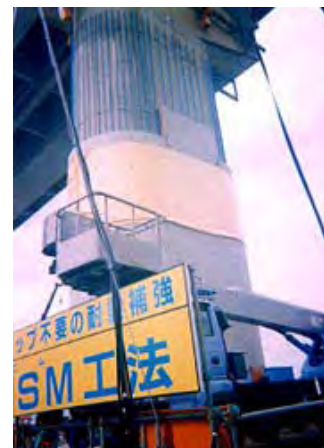
Figure10-40 Méthode de chemisage en BA
