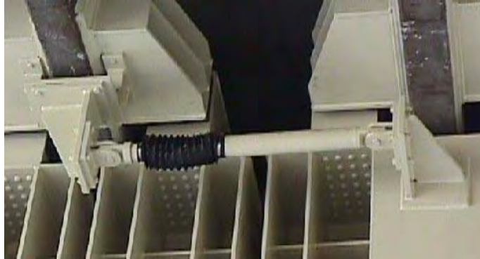
Figure 10-37 Exemple de contrôle par amortisseur du déplacement
