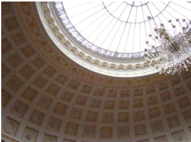
Photo 9-9 Lucarne et toiture de la salle de l'assemblée
