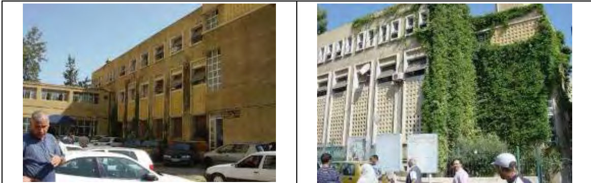
Photo 9-13 Vue générale de l'Hôpital Mustapha
