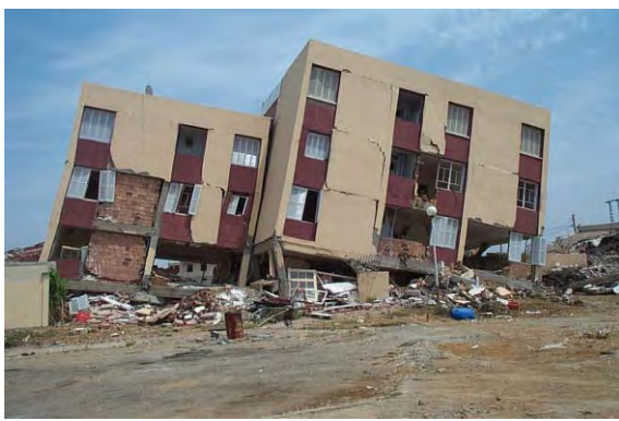
c) Destruction par effondrement de poteaux
