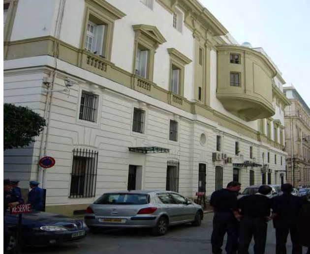
Photo 9-8 Façade derrière (ouest)
