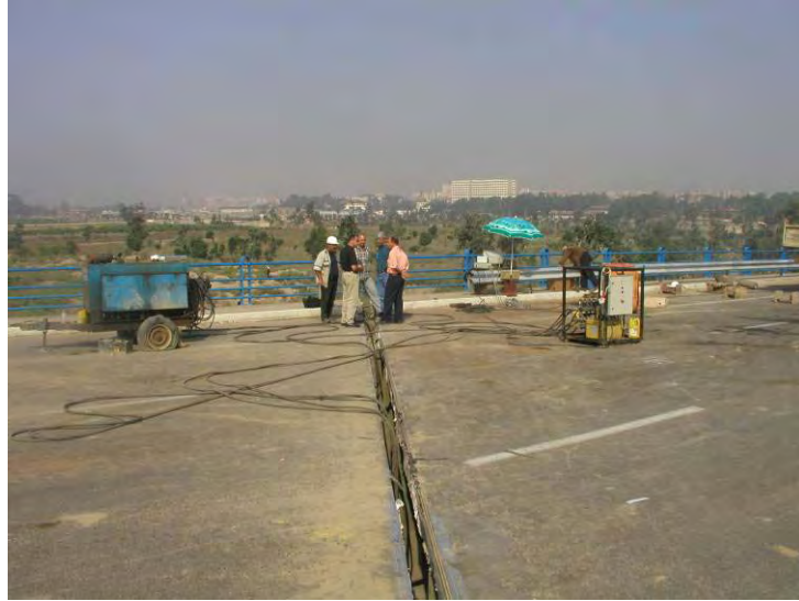
Figure 6-27 Déplacement d'une poutre du pont d'EL HARRACH
