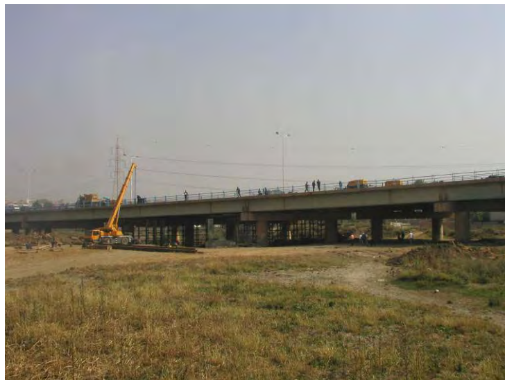
Figure 6-26 Vue du pont d'EL HARRACH
