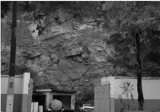
Photo 5-3 Pente au mur de roches
