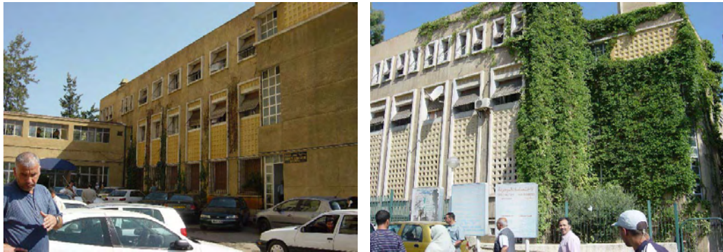
Photo 9-5 Vue générale de l'hôpital Mustapha
