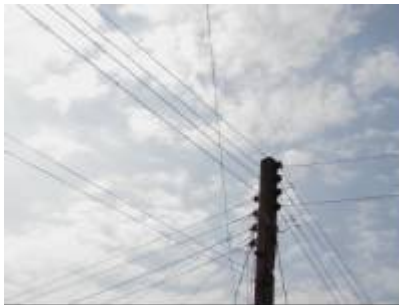
コンクリート柱
