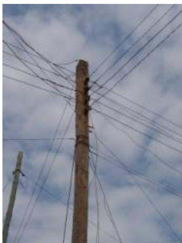
ECGの低圧（430V）配電線
