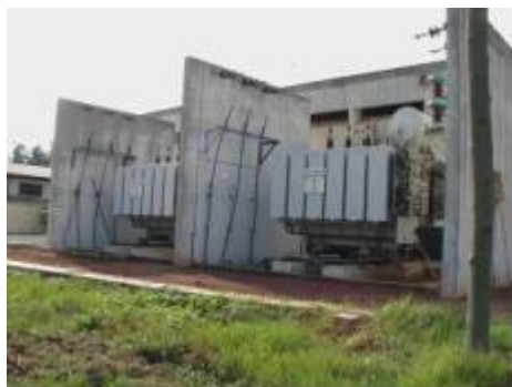
33/11kV 変圧器 (容量は 20MVA)
