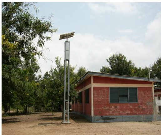
2000年に設置された太陽光発電街灯
