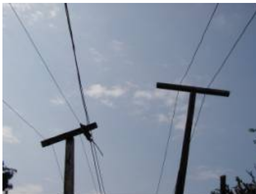
ECG管内（Accra West）の低圧不正接続線
