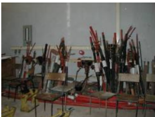
ケーブル接続訓練用機材
