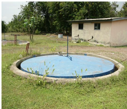
バイオガス発生設備と発電機小屋
