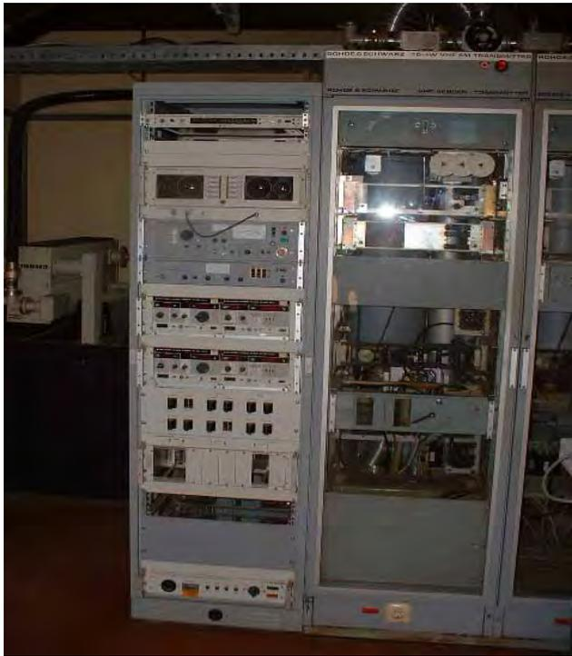
電力増幅部の交換部品が入手できず、減力運転している既存の FM 送信機 (R&D 社製 (ドイツ))。ヤウンデの機器同様、丁寧に使用されているが各種ユニットが取り外され、修理不能の状態となっている。
