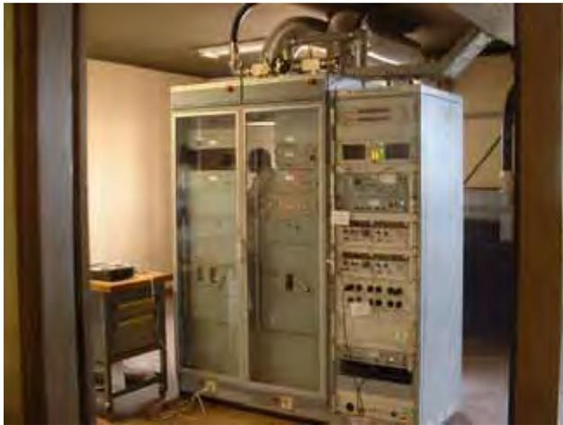
周辺環境と整合せず減力運転中の FM 送信機 (DB 社製: 写真右) と、交換部品が入手できず励振器がはずされたまま運用停止している FM 送信機 (R&D 社製: 写真左) とともに清掃は行き届いており、外観はきれいである。
