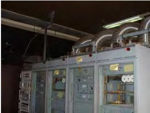
交換部品が入手できず減力運転している既存の FM 送信機 (R&D 社製 (ドイツ))。古い機材を丁寧に使用しているが、故障した励振部は、取り外されたままである。
